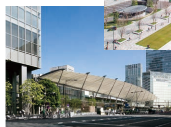
東京駅八重洲口駅前広場
