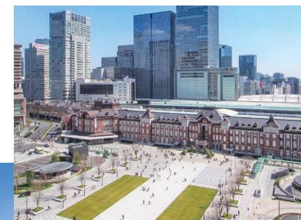
東京駅丸の内口駅前広場
