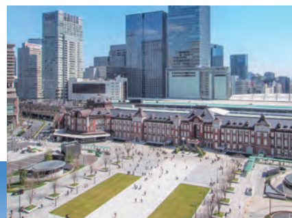
東京駅丸の内口駅前広場
