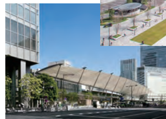
東京駅八重洲口駅前広場
