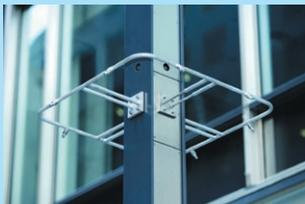
ノズルの先から人工の霧が吹き出て、周囲の温度を下げていく「ドライミスト」
